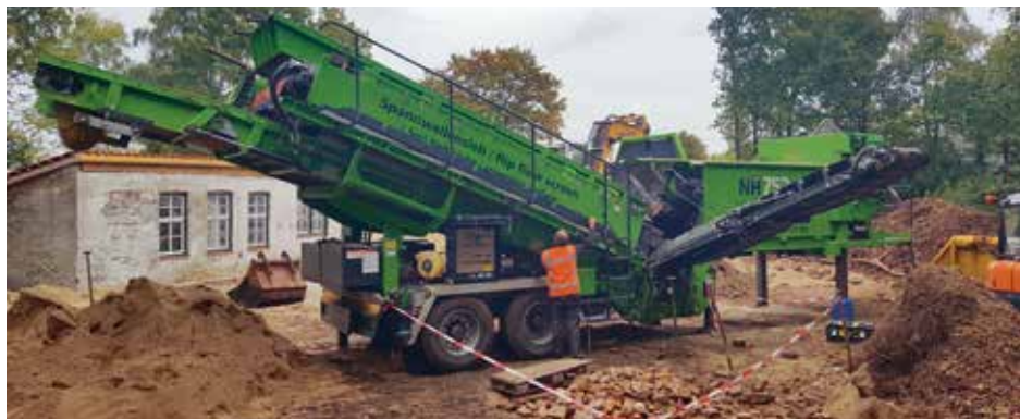
Foto 1. De besmette grond wordt afgegraven en vervolgens gezeefd, zodat het afgegraven profiel met het autochtone zand hersteld kan worden. (Foto: Martijn van de Loo)
