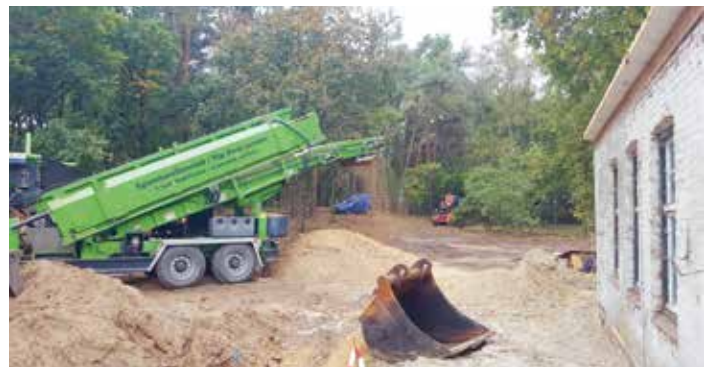
Foto 3. Het afgegraven materiaal wordt gezeefd om stukjes duizendknoop te verwijderen.
