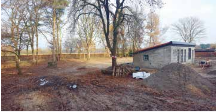
Foto 4. Het terrein in Borkel enkele weken na uitvoering van de graaf- en zeefwerkzaamheden.
