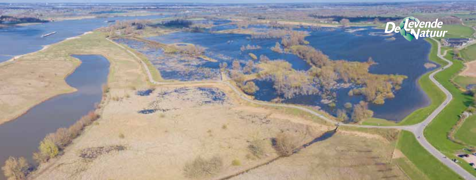
Foto 1. Overstromingsvlakte Buiten Ooij bij Nijmegen, 21 maart 2020. Rechts de winterdijk, links de Waal en een gegraven nevengeul. De waterhoudende afvoer (midden onder) kruist de zomerdijk bij de Waardse Sluis, waarmee het water wordt vastgehouden na een hoogwater. (Foto: Remco Versluis)
