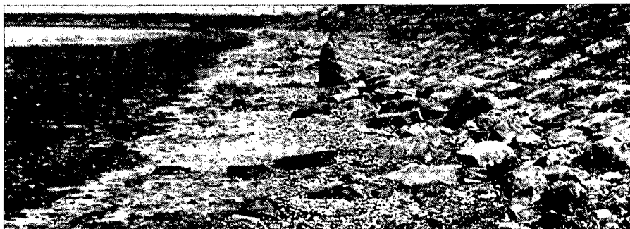
fig. 1. De steenglooïing van de Balgzanddijk.
