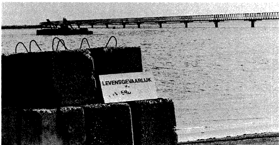
Manipuleren met de pijlerdam: levensgevaarlijk! (foto: H. J. van Oosten)
