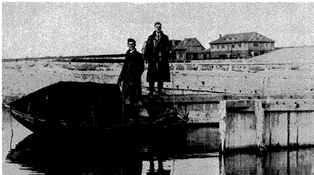
De auteur in de boot met een bioloog-assistent bij een sluis in de juist drooggevalle Wieringermeer. Alle transport van en naar de varkensstallen ging met dit bootje.
