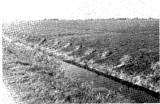
Resultaat nadat slootkant afgestoken is met spade.
