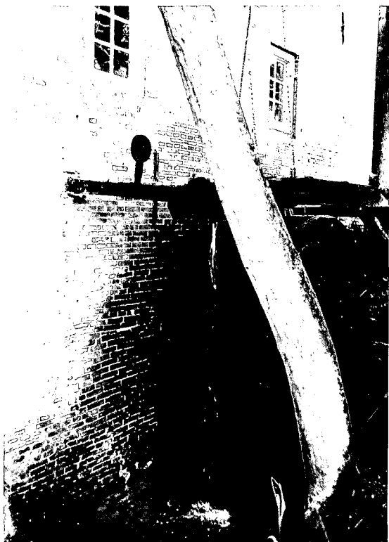
Molen van Frans te Vasse aan de Mosbeek. Boven-slagrad (foto: W. J. de Leeuw)
