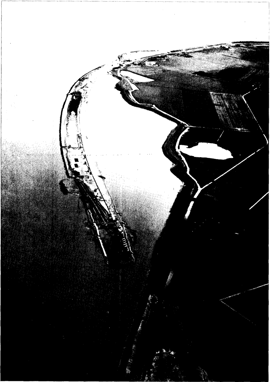
De aanleg van de nieuwe dijk ter hoogte van Oosterend in september 1978: het Wagejot ontstaat. (luchtfoto: J. Nauta, Texel)
