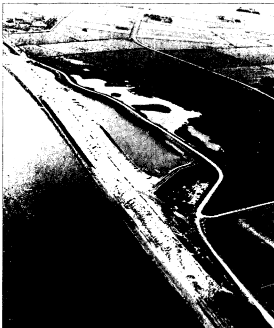
Ottersaat, vlak na de aanleg van de nieuwe dijk in september 1977. De oude dijk is nog niet afgegraven. (luchtfoto: J. Nauta, Texel)
