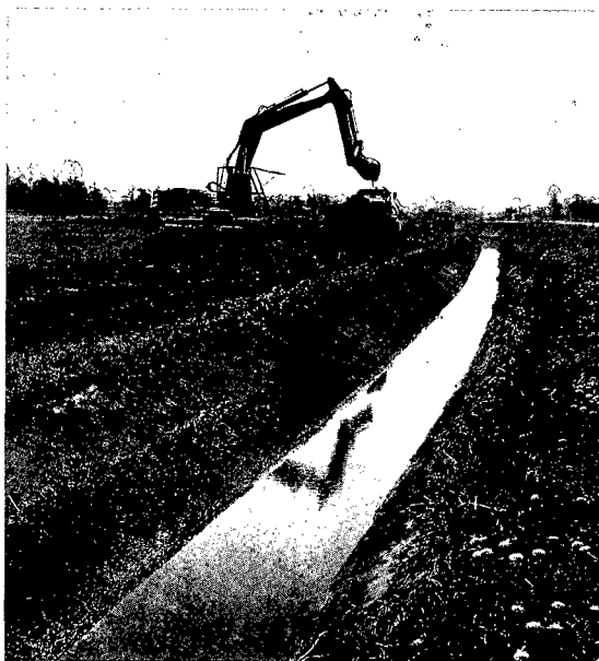
Het graven van een waterloop bij de ruilverkaveling Giethoorn-Wanneperveen (1982). De verdergaande versnelling van de afwatering en de verlaging van het grondwaterpeil zijn van enorme invloed op de natuurlijke waarden van ons land.
