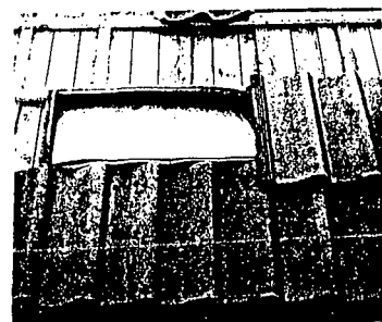
Fig. 15. Het nestbakje is op de tengels tussen de panlatten aangebracht. De schuimstrook rondom bepaalt de afmeting van de nestruimte.
