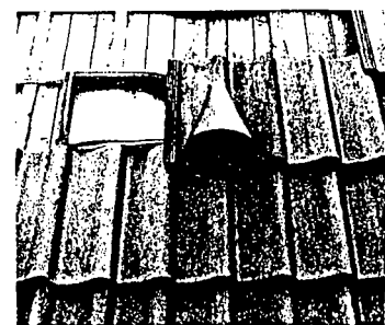
Fig. 16. Met het plaatsen van de gierzwaluwenpan wordt de schuimstrook in elkaar gedrukt.
