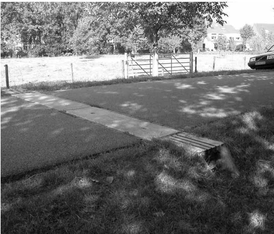
Foto 1: Weg zonder permanente geleidingswanden.
