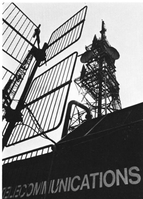
Bij bediening en bewaking van de productieplatforms speelt telecommunicatie apparatuur een zeer belangrijke rol. (Foto NAM)
