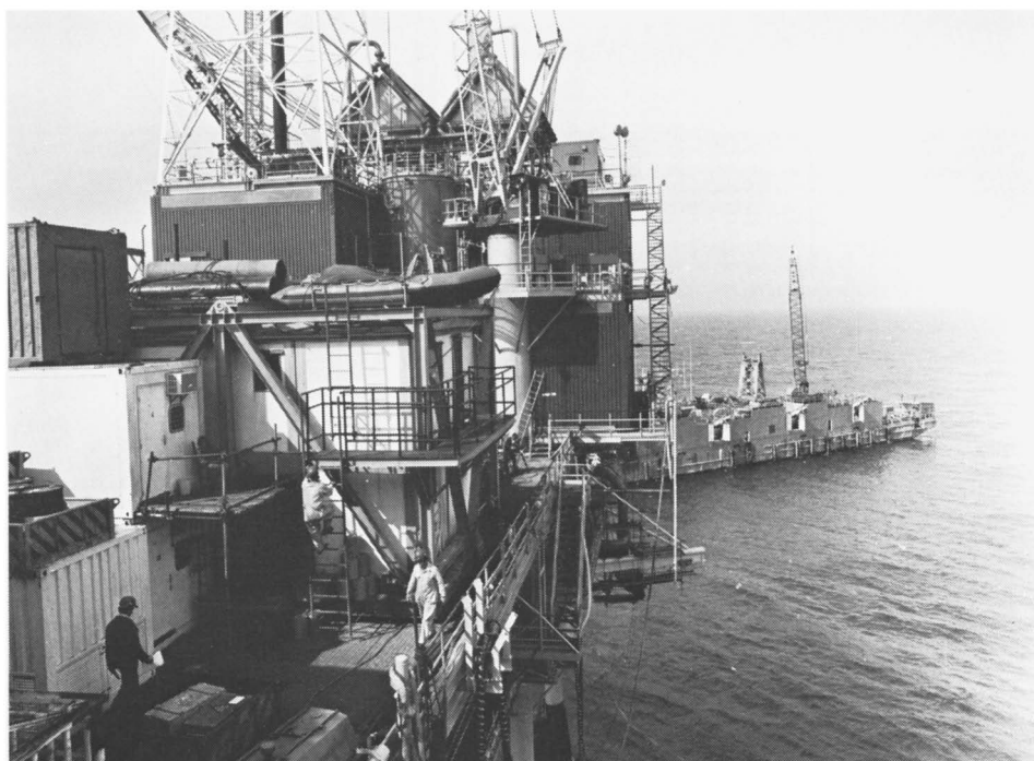
Platform in aanbouw, op de achtergrond het pijplegschip 'ORCA'
