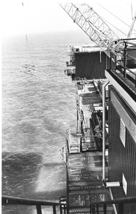
Een van NAM's platforms in aanbouw op de Noordzee. (Foto Rini Boon, Dordrecht)
