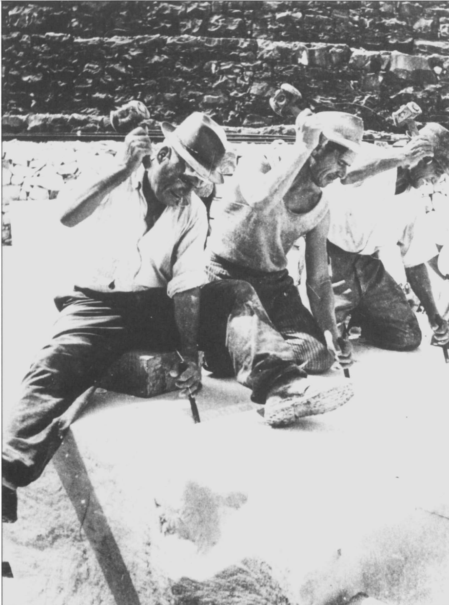
Fig. 9. Het beitelen van de 'formelle', de gleuven waarin wiggen werden gedreven om het marmer te doen splijten (Mannoni & Mannoni, 1985).
