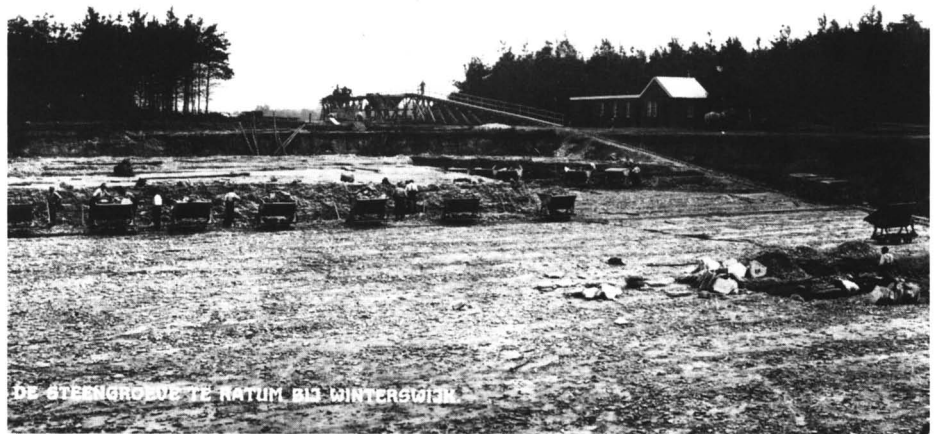
Fig. 1. De steengroeve medio 1933, minder dan een jaar na het begin van de winning van de kalksteen. Het smalspoor leidde vanuit de groeve naar een brug over de weg. In die brug bevonden zich drie trechters, waardoor de kalksteen in de daaronder staande vrachtauto's werd gestort. De brokken kalksteen werden toen nog uitsluitend als wegverhardingsmateriaal gebruikt.
