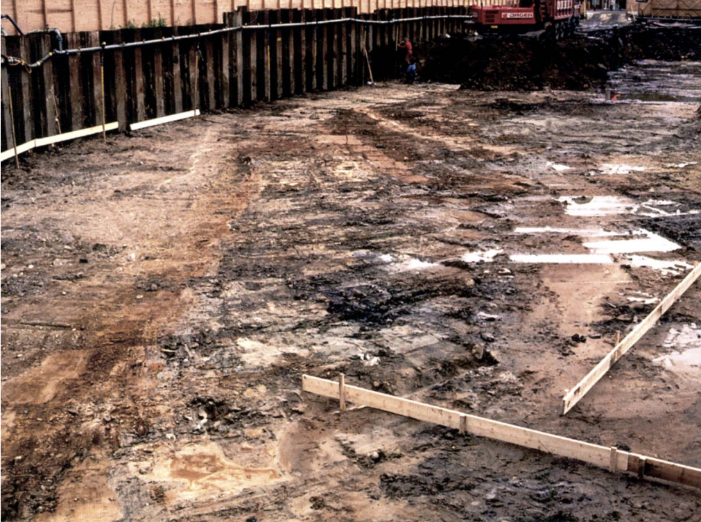
Afb. 16. Overzicht van de bouwput van het Prefecten-hof aan de Kreupelstraat in Groningen met lateraal gestuwde glacigene afzettingen uit het Saalien. De gestuwde afzettingen lopen parallel aan de as van de Hondsrug.
