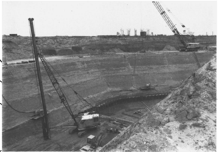
Afb. 2. Geologische tijdtabel (links); profiel en stratigrafische kolom van een bouwput bij Kallo in 1974 (midden) en foto van de bouwput voor het 4e havendok te Kallo bij Antwerpen, zomer 1985, waarin diverse lagen te zien zijn (rechts). Ter plaatse blijken de Zanden van Kattendijk (ZvK) donkergrijs, de Zanden van Oorderen (ZvO) geelachtig van kleur. Verklaring van de overige afkortingen (ook bij andere afb.): KvB = Klei van Boom; PMB = Postmioceene basisgrindlaag van de Zanden van Kattendijk; 1e en 2e SB = schelpenbanken in de Zanden van Oorderen; 1 = hiaat Mioceen; 2 = hiaat in Pliocene (Zanden van Luchtbel); 3 = hiaat Pleistoceen. Profiel: A.W. Janssen. Foto: auteur.
