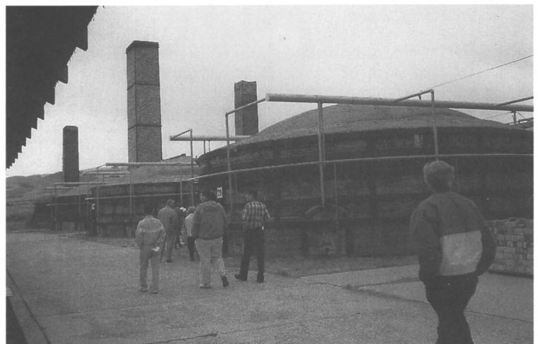
Afb. 5. De ronde, ietwat tonvormige ovens waarin de stenen gestookt werden.
