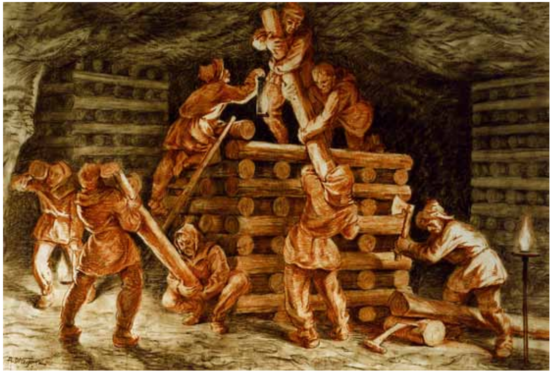
Afb. 3. Bouw van een ondersteuningsconstructie ter voorkoming van instorting van het plafond in de exploitatiekamer. Schilderij van Alfons Dlugosz (1902 – 1975). Bron: Muzeum up Krakowskich Wieliczka (het Museum 'Wieliczka zoutmijn' in Wieliczka, Polen).
