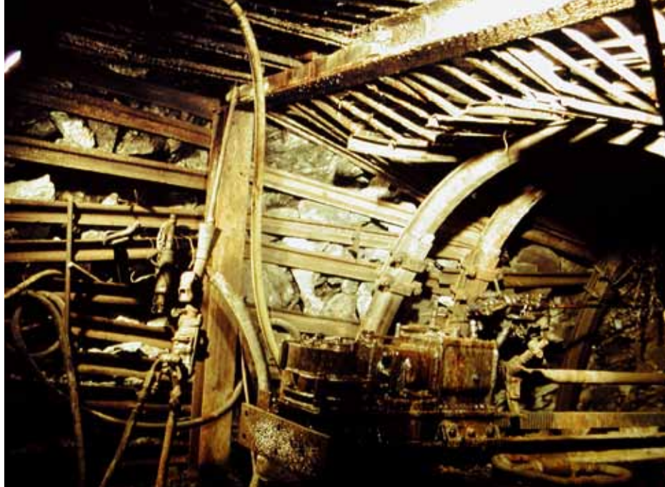
Afb. 4. De mijngangen is hier gestut met stalen steunen die zo aan elkaar vastzitten dat ze langs elkaar kunnen schuiven bij bewegingen en niet met-een afbreken. Rechtsonder staat een compressor die gebruikt werd voor de pneumatische hamers.
