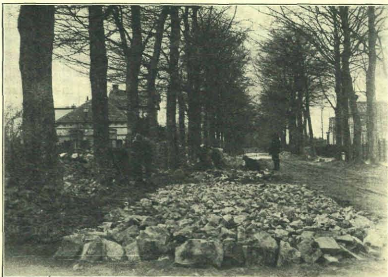
2. De groote kalksteenbonken als grondslag voor den bitumenweg, de zettters aan het werk, straks gaat de wals er over.
