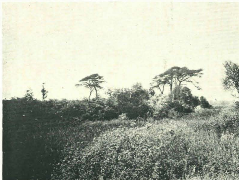
Fig. 3. Voorwerk op de Engelaar aan de Groeper kade.
