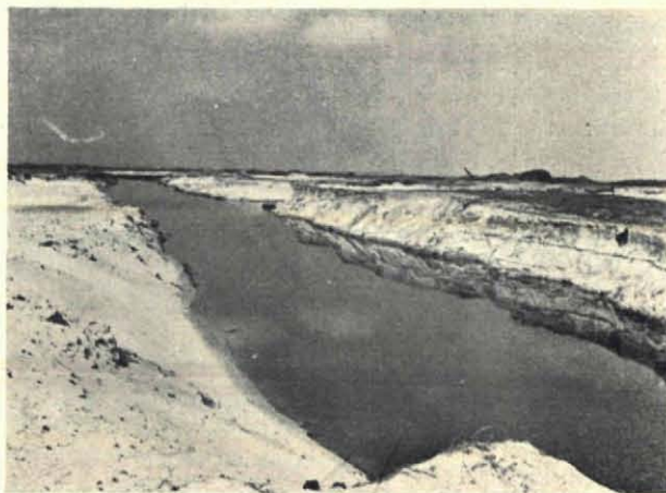
Fig. 3. Een nieuw kanaal.
