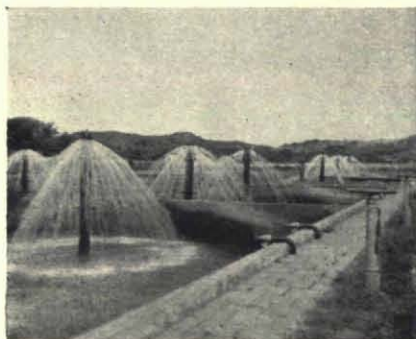
Fig. 1. De waterwerken van de Provinciale Waterleiding.
