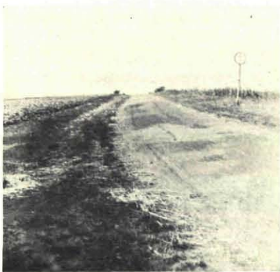
Fig. 5. Asfaltweg van Veenhuizen naar Alteveer, lopende over de Onstwedder Es. De horizon op 75 m afstand.
