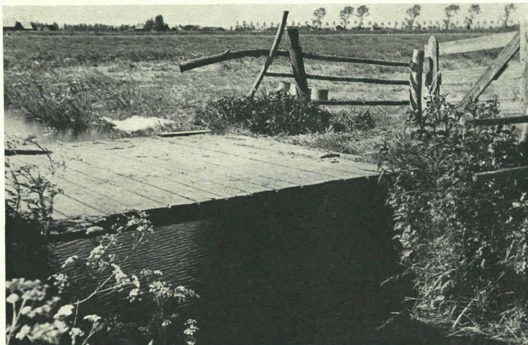
Fig. 4. Houten bruggetje op houten liggers (type IV).
