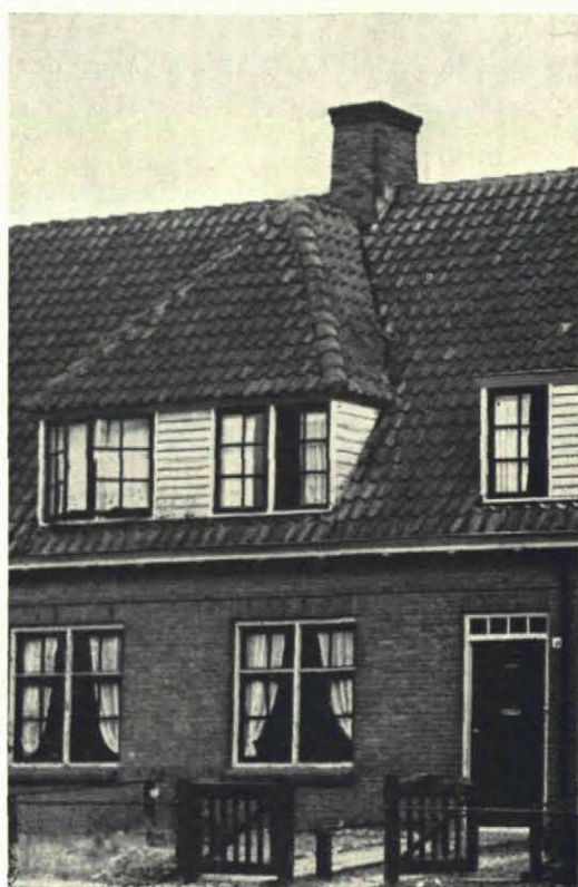
Fig. 1. De dakkapel van de huizen in een buurt in Wageningen vormt een gemakkelijk bereikbare broedplaats van Gierzwaluwen.
