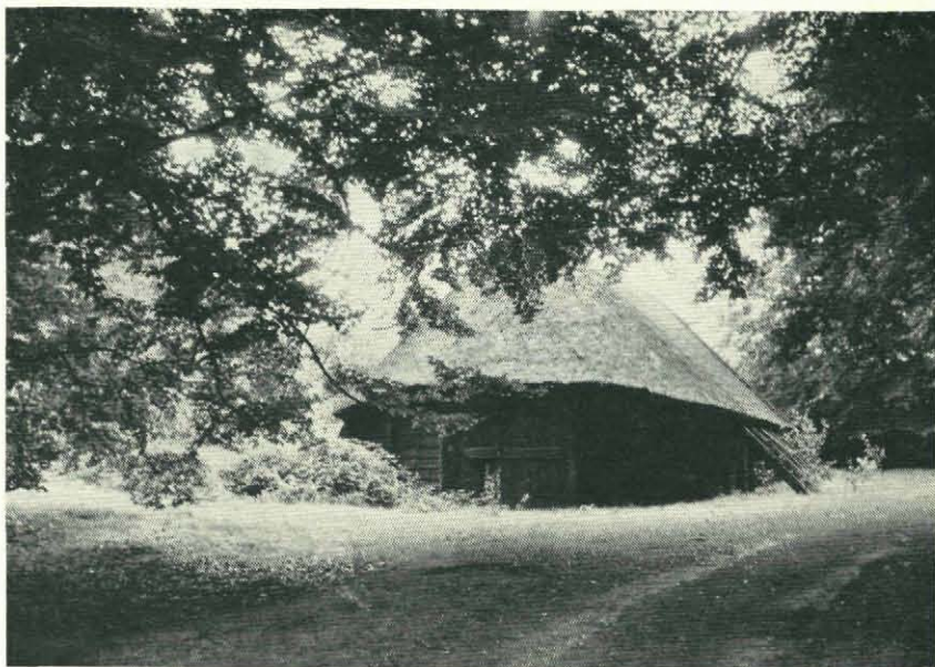
Fig. 1. Een der beide in oude trant herbouwde schaapskooien op het landgoed „Hoog Buurlo“.
