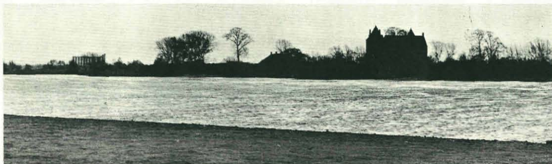
Fig. 2. Slot Loevestein met (links) de verfoeide silo. Foto G. Hofenk.
