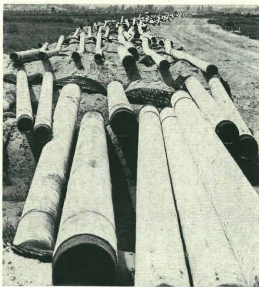
Fig. 3. Aanleg van pijpleidingen in het Oude Land van Strijen.
