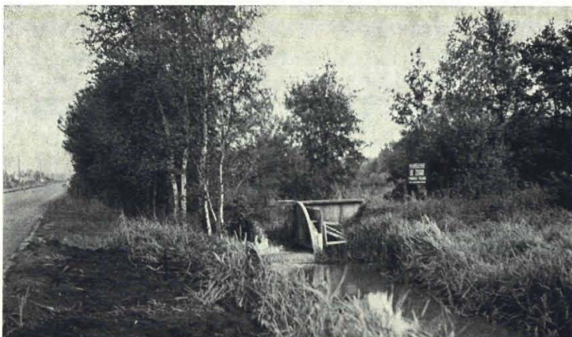
Fig. 2. Betonnen drempe , waarmee het water ook volledig kan worden vastgehouden.
