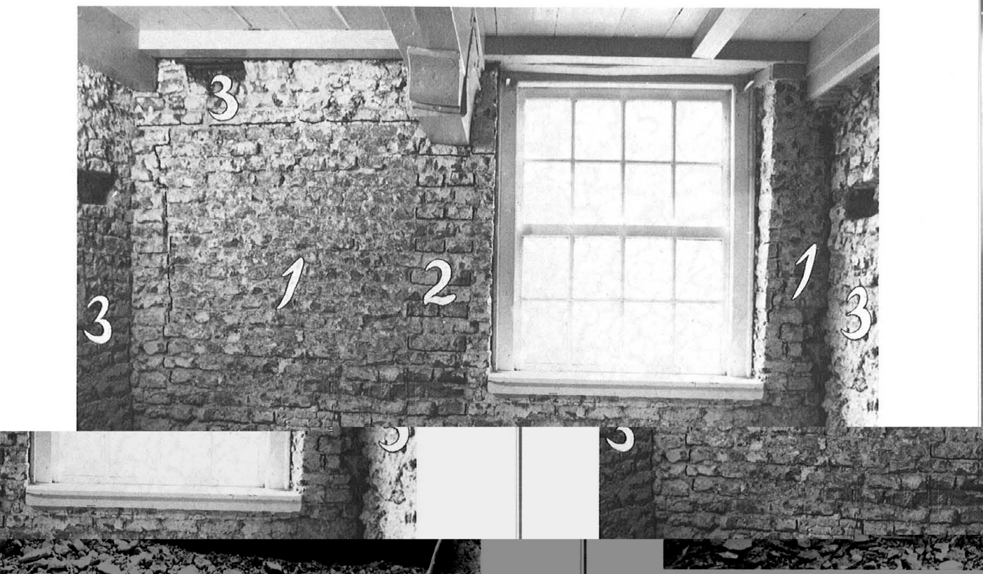
Fig. 2. Springweg 110, westmuur, verdieping. 1. M gebroken steunbeer; 3. metselwerk van rond 1500
