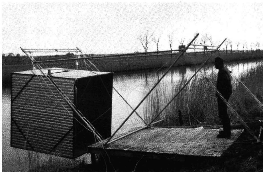
Fig. 3. Installering van de stekelbaarspassage in het Kanaal Schagen-Kolhorn. Installation of a fishway in the 'Kanaal Schagen-Kolhorn'.
