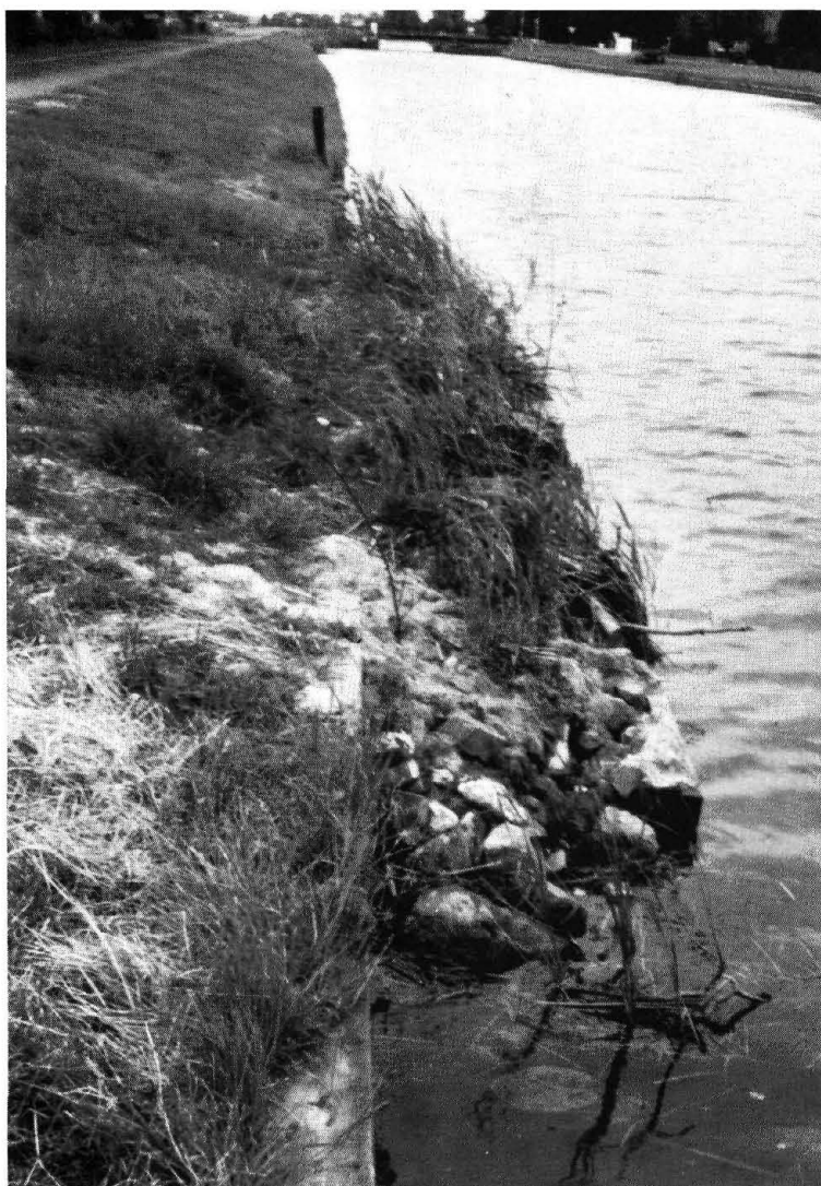
Foto 5. Fauna-uitstapplaats voor de damwand, opgevuld met steen.
