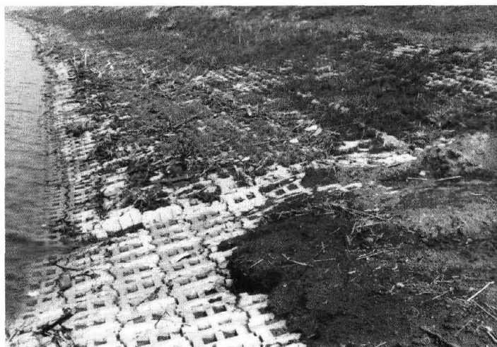
Foto 6. Oeververdediging met blokkenmat. Bankprotection with fixed open stone layer.
