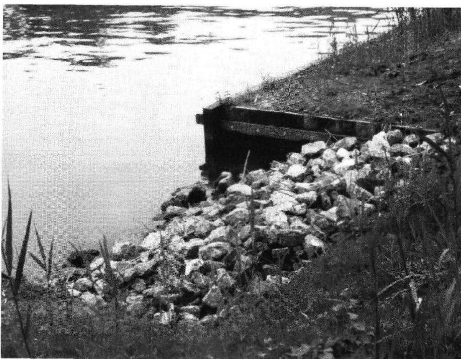
Foto 2. Fauna-uitstapplaats achter de damwand (Twenthekanaal). Fauna-out-step behind the sheetpiling (Twenthekanaal).
