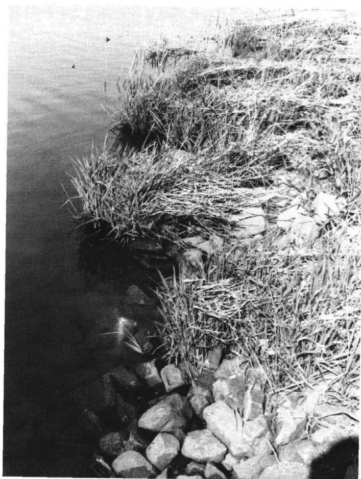
Foto 7. Oeververdediging met stortsteen. Bankprotection with quarry.
