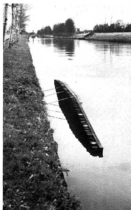
Foto 4. Fauna-uitstapplaats voor de damwand, nog niet opgevuld met steen. Fauna-out-step before the sheetpiling, not yet filled up with stones.
