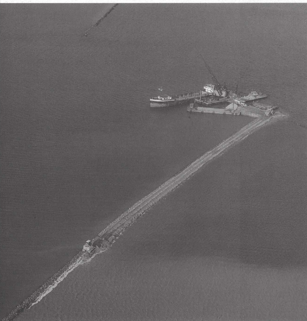
Foto 2. De oeververdediging bestaat uit stenen dammetjes op ongeveer een meter beneden de gemiddelde waterstand. Hierdoor worden ondiepten en slikken bij een lage waterstand beschermd tegen erosie en ontstaat een goed rust- en foerageergebied voor vogels (foto: Aerocamera - Michel Hofmeester bv.).
