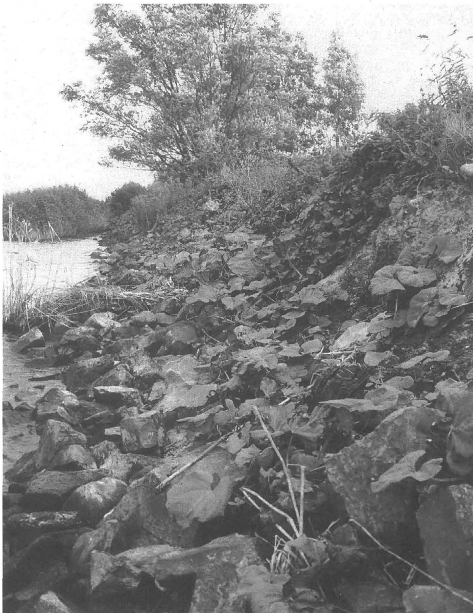
Foto 3. Het Peneiland heeft rondom een dijk met een talud van basalt en andere steenblokken (foto: Ruud Wolterman).
