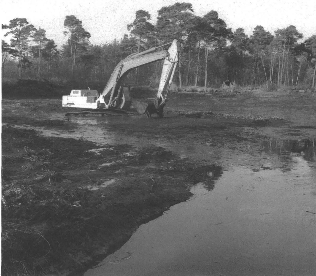
Foto 2. Begin 1994 is de gehele sliblaag uit het ven verwijderd. In eerste instantie gebeurde dit door een graafmachine op rupsbanden; het laatste deel werd vanwege de optredende kwel verwijderd met een zuigtank (foto: Henk Pijnenburg).
