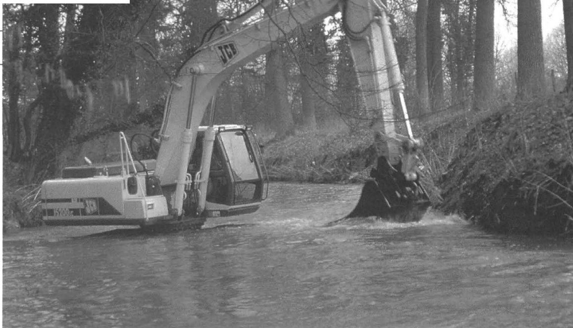
Het weghalen van oeverbeschoeiingen in de Geul bij Valkenburg.
