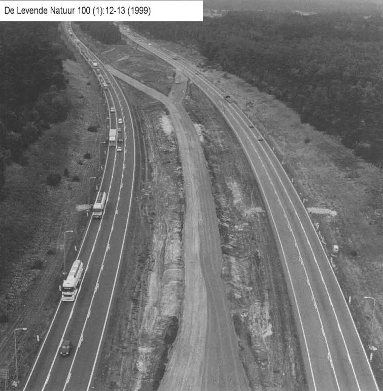
Op deze plaats wordt het 'Harm van Veen-ecoduct' gebouwd. In de middenberm van de A1 (tussen Amersfoort en Apeldoorn) is een tijdelijke rijbaan aangelegd, zodat kan worden doorgebouwd zonder het verkeer te hinderen. De A1 doorsnijdt hier de Veluwe en vormt daarmee een haast onneembare barrière voor dieren (foto: Meetkundige Dienst, Rijkswaterstaat).
