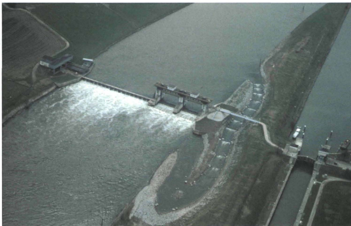
Moderne lange V-vormige bekkenpassage in de Maas bij Belfelt.
