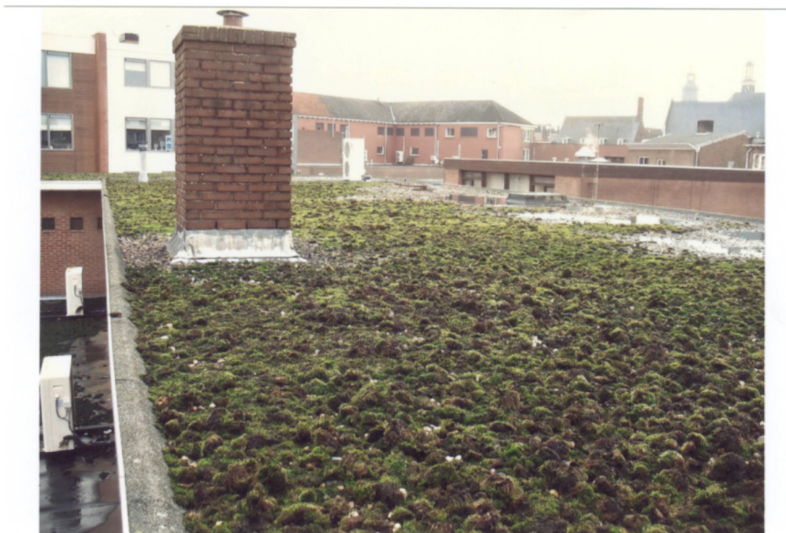
Foto 1. Massavegetatie van Wollige bisschopsmuts ( Racomitrium lanuginosum ) op een plat dak in het centrum van Zutphen.
