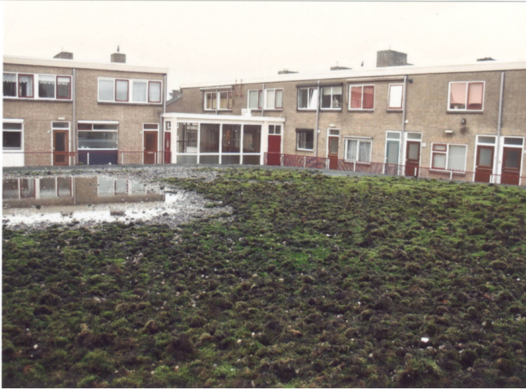
Foto 2. Massavegetatie van Wollige bisschopsmuts ( Racomitrium lanuginosum ) op een plat dak in het centrum van Zutphen.
