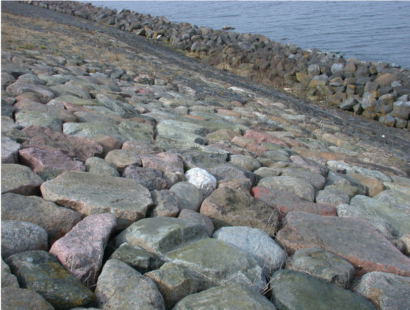
Figuur 1. Aandijk. Vooraan graniet, achter links bazalt, boven stortsteen (foto: A. Aptroot)
