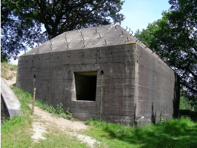
Figuur 2. Betonnen schuilplaats op Fort Ruigenhoek. In 1989 was deze bunker sterk beschaduwd, ontoegankelijk en had een rijke bryoflora. De nieuwe beheerder heeft het struikgewas verwijderd en alle mossen zijn verdwenen (foto: H.C. Greven, juni 2010).
