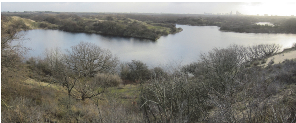
Figuur 3. Een grote infiltratieplas vanaf het noorden gezien.
