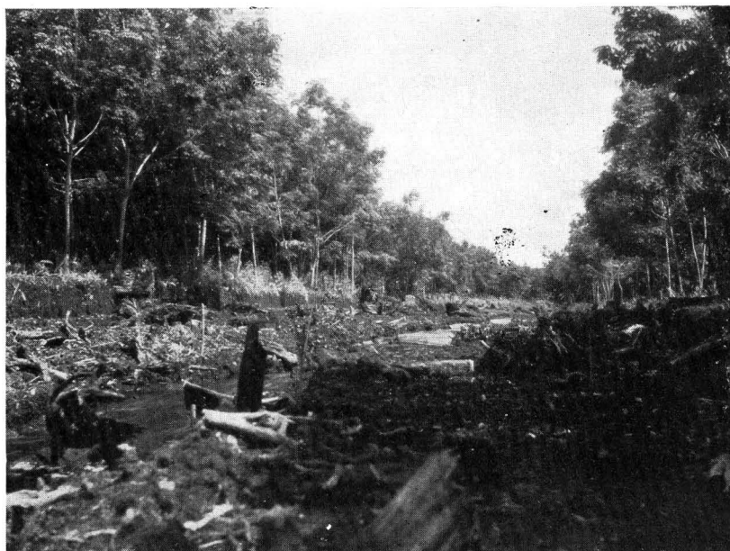
Fig. 3. Kanaal, gegraven in het veengebied van West Borneo (Soengai Raja). Men lette op de vele stammen en op het snel afvlietende water.
