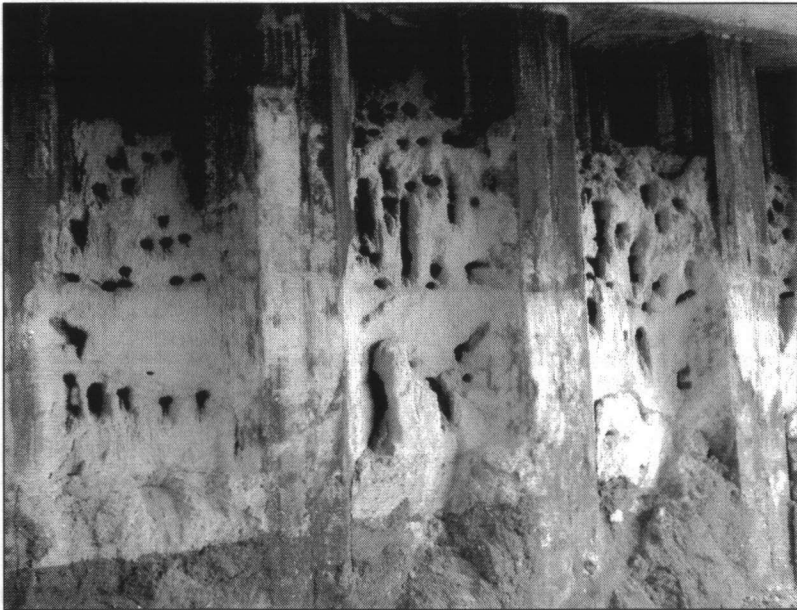
De damwand met een Oeverzwaluwkolonie bij Schiphol-Rijk. Foto: Marcel Schalkwijk
