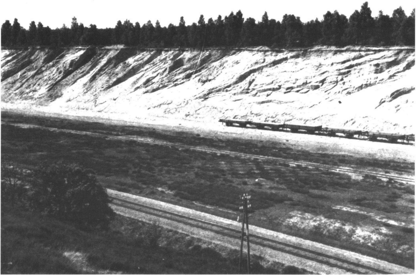
Fig. 2 Noordwand van de spoorwegdoorgraving bij Nijverdal in 1942. De schubvormige bouw was toen nog duidelijk zichtbaar. Deze (Sallandse) stuwwal is in alle opzichten veel groter dan de Needsche Berg
