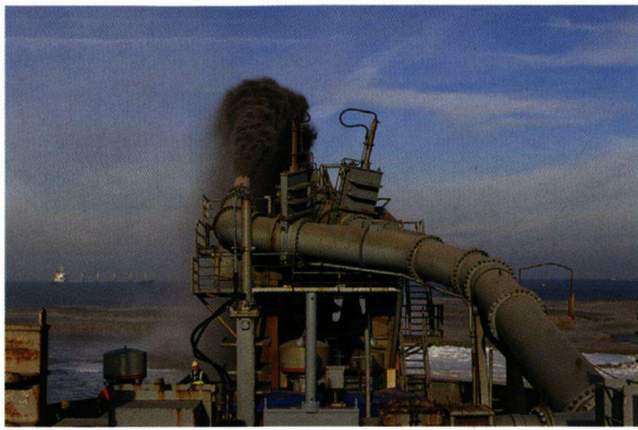
Fig. 18 Sleephopperzuiger volop in actie: het nieuwe land wordt al zichtbaar en bestaat uit Laat-Pleistoocene sedimenten uit het zandwingebied dat grenst aan de Eurogeul. Een nieuw "El Dorado" voor WPZ-leden.
