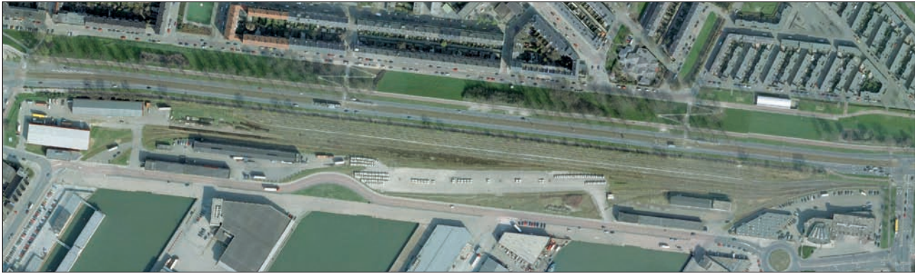
▲ Luchtfoto van het spoorwegemplacement aan de Marconistraat te Rotterdam. (Gemeentewerken Rotterdam)
