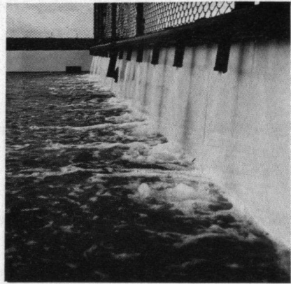
Detail van een kool. Het gefilterde water wordt met kracht in het bassin teruggespoten, waardoor een goede aëratie wordt verkregen. Op de achtergrond één van de afroombotten.
