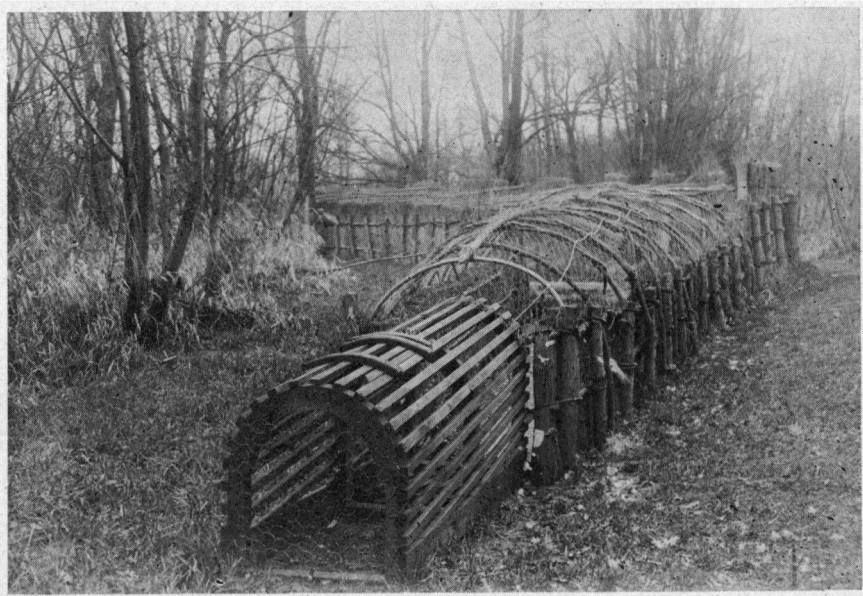
Het einde van de pijp met het vanghok en klep
